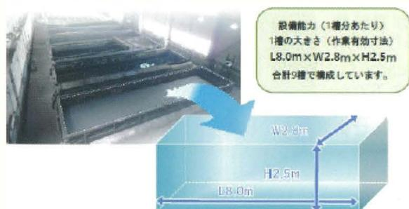
図・6 リン酸塩処理槽の規模
