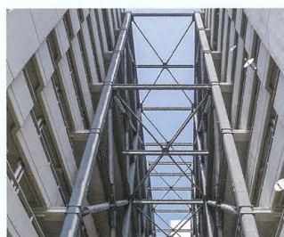
⑪耐震補強
