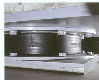
⑫免震装置
