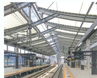
④駅舎屋根
