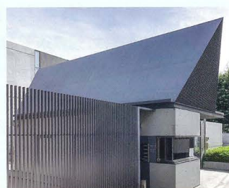
⑩建屋外部屋根
