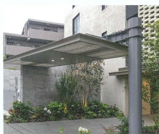
⑦エントランス屋根
