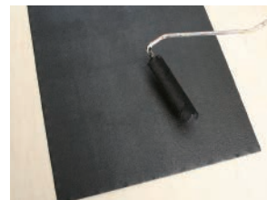
④アクアラスストップを塗布(2回目)
