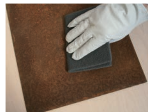
②サンドペーパー、研磨布等で、表面の浮いた赤サビをとる
